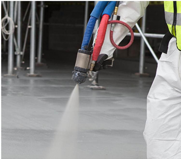
La construction de l'aéroport en Irlande exigeait une solution d'étanchéité pour le sous-sol, en particulier pour les murs et les colonnes de béton armé. Situé sur un site en pente, les ingénieurs ont conçu un système de drainage sous la dalle, car le sol présentait des irrégularités structurelles. Par conséquent, une membrane adaptée pour une utilisation en zones humides était également nécessaire.
