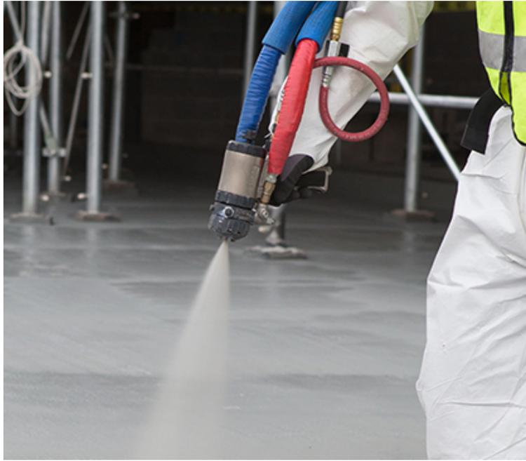
Les principaux défis rencontrés lors de la construction à l'aéroport étaient d'installer un système d'étanchéité qui satisfaisait à toutes les exigences du programme pour les entrepreneurs concernant la vitesse d'installation, la rapidité d'accès au site après les travaux et la résistance à la détérioration et aux dommages.
