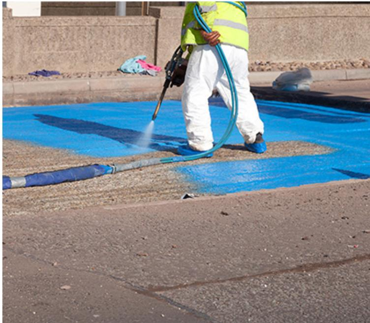
La conception de cette infrastructure de transport nécessitait un système avec des propriétés hydrofuges et de rétention d'eau en même temps. Cela a permis de garder l'eau dans le canal et fait en sorte que celle-ci ne pouvait pas pénétrer le tunnel de béton.
